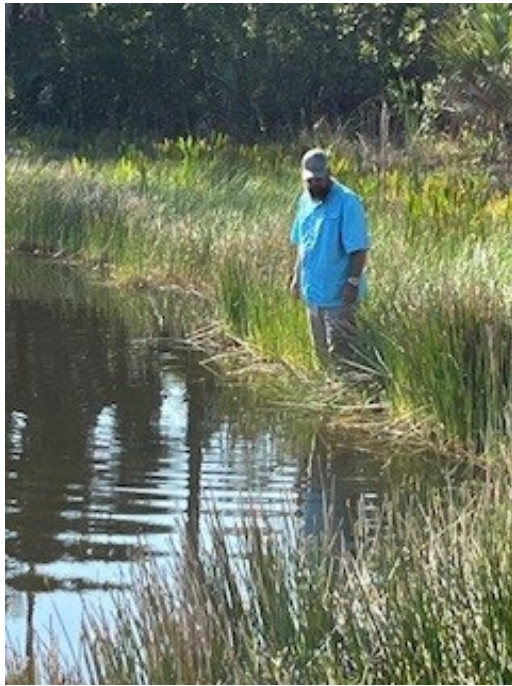
HEADWALL (SUBMERSED) IN LAKE #24
